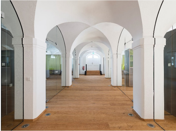
Sanierungsbeispiel: Büros im Zehntstadel 1
